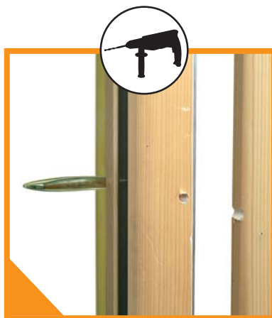
PERFORAZIONE DELL'ANTA E MOVIMENTAZIONE DELLA FERRAMENTA
