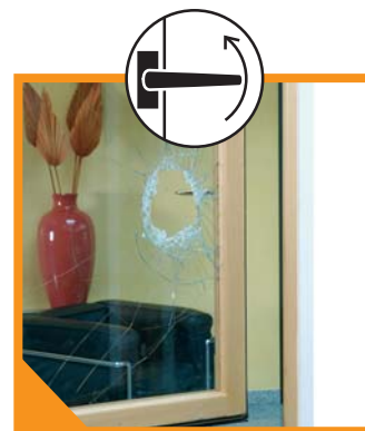
ROTTURA DEL VETRO E ROTAZIONE DELLA MANIGLIA DALL'ESTERNO
